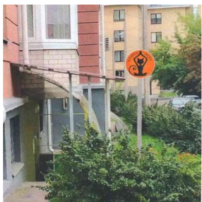
Панель на опоре
